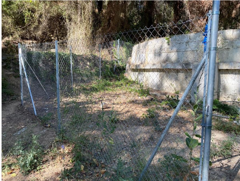
Figura 18. Vista del tancament perimetral del Dipòsit de Gatell.
