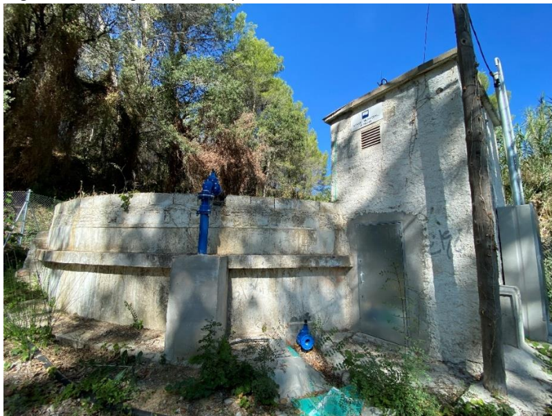
Figura 19. Vista general del Dipòsit de Gatell.
