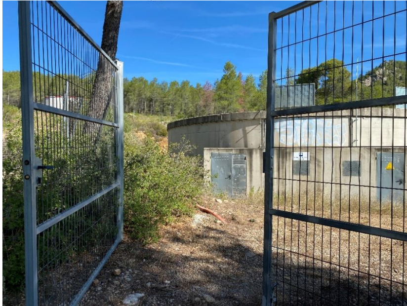
Figura 14. Vista de l'accés al Dipòsit de Can Coral amb el seu tancament perimetral corresponent.
