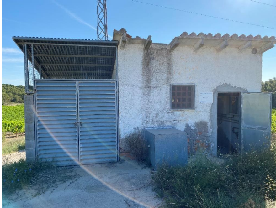
Figura 4. Vista general de la captació del Pou Hill.
