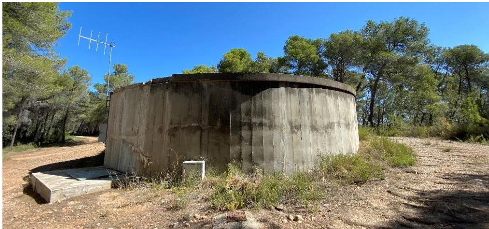
Figura 28. Vista general del Dipòsit del Terme.
