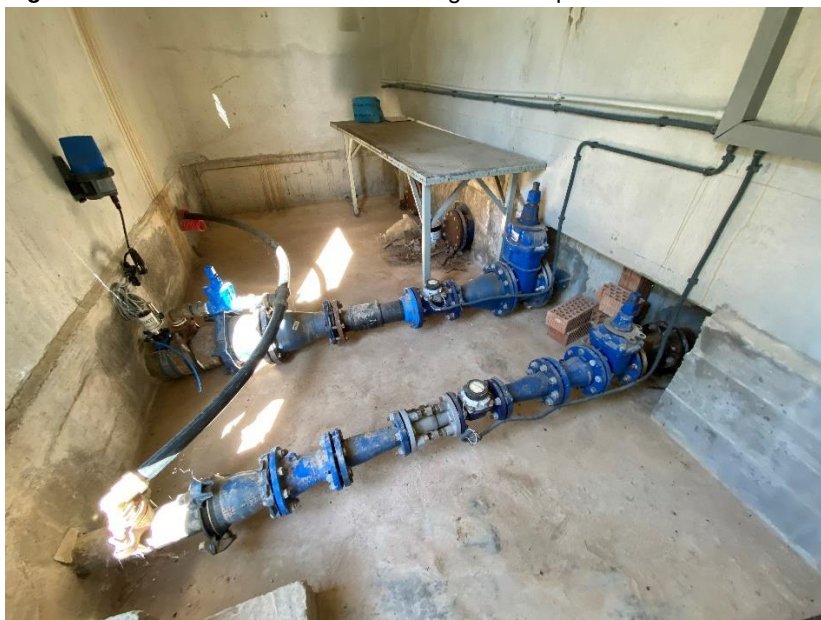
Figura 17. Vista detall de les sortides d'aigua del Dipòsit de Can Coral.
