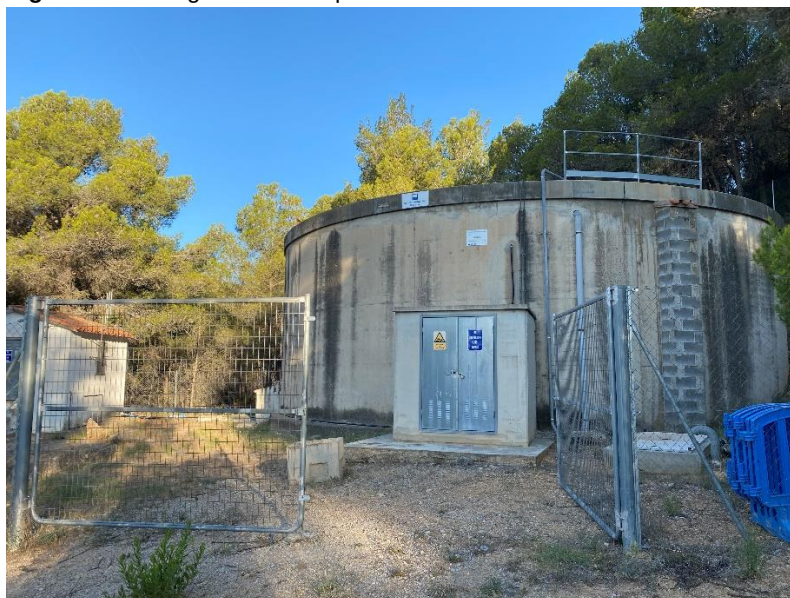
Figura 23. Vista general del Dipòsit de les Costes.
