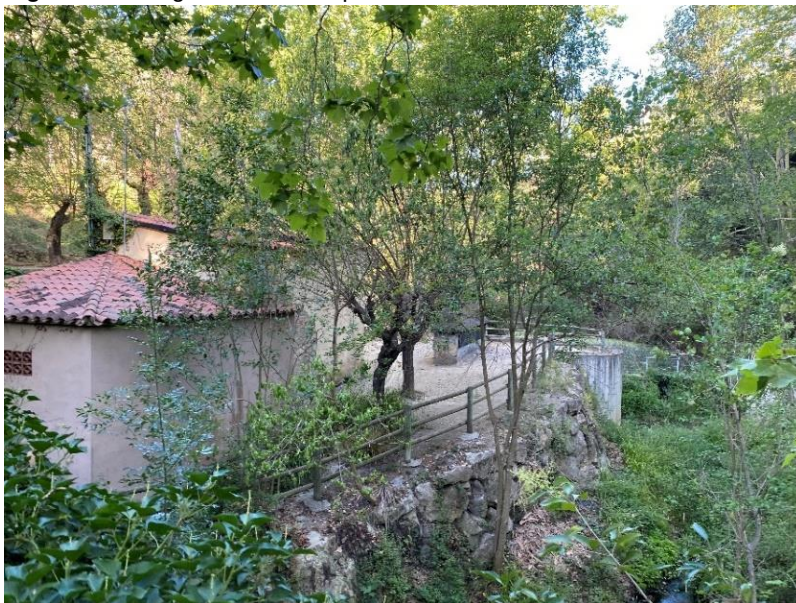
Figura 7. Vista general de la captació de la Mina de les Dous.
